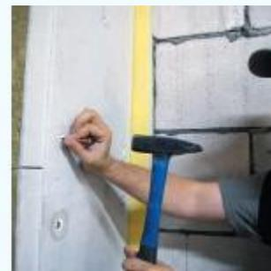
по длинной стороне. Панели устанавливают следующим образом: панель прикладывается к стене, непосредственно через виброузлы просверливаются отверстия в стене/потолке глубиной 60 мм.
