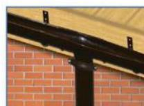
8. Установить сливную воронку. Передний край воронки заложить на передний фланец желоба. Повернуть воронку вперед до защелкивания переднего фланца на торцевом фланце желоба. Длину напуска желоба в воронку подобрать по сливному отверстию в воронке. После завершения установки зафиксировать воронку на желобе скатием лепестков, расположенных на задней части воронки. Края желобов обработать силиконом.
