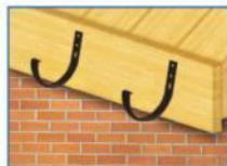
1. Рассчитав эффективную площадь крыши, определяем количество и расположение углов желоба и сливных воронок. На торцевой доске обозначить положение углов желоба и сливных воронок. С обеих сторон угла и воронки, на расстоянии 10-15 см от края, монтируются держатели желоба. При размещении сливной воронки, что бы уменьшить количество резов, по возможности учесть длину желобов и соединителей.
