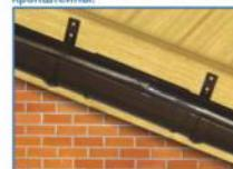
6. Соединить желоба при помощи соединительных муфт желоба. Передний край соединителя надеть на передний край желоба. Повернуть соединитель вниз и вперед до защелкивания желоба в соединителе. Выставить необходимое расстояние между краями желобов, после чего зафиксировать желоба скатием лепестков на задней части соединителя.
