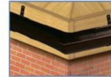
10. Установить углы на желобе. Вставить передний фланец желоба в передний фланец угла и защелкнуть задний фланец желоба в торцевом фланце угла. После установки угла желоба зафиксировать желоб скатием лепестков на угле желоба. Края желоба обработать силиконом. При размещении углов желоба учсть вылет крыши, край крыши должен быть на расстоянии  $\frac{1}{4}$  диаметра угла желоба от края кровли.
